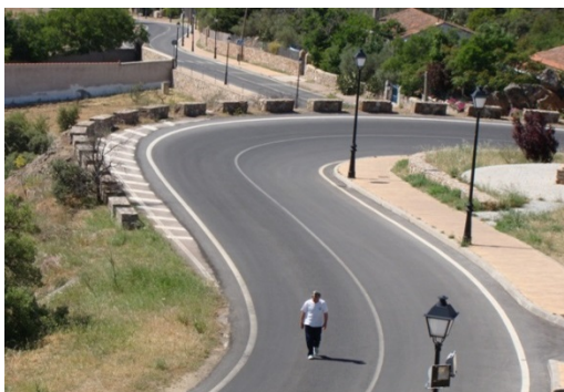
Figura 2. Curvas en la carretera
