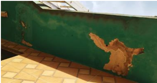
Fig.11. Imagen de la Losa 7.
