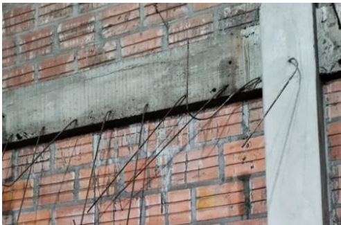
Fig. 9. Viga 2 con armaduras en espera.
