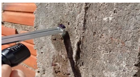
Fig. 2. Medición de la profundidad con un calibre.
