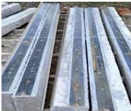
Fig. 3. Refuerzo metálico en vigas.
