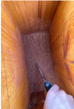
Fig. 4. Escarificación superficial de la capa para asegurar la adherencia.
